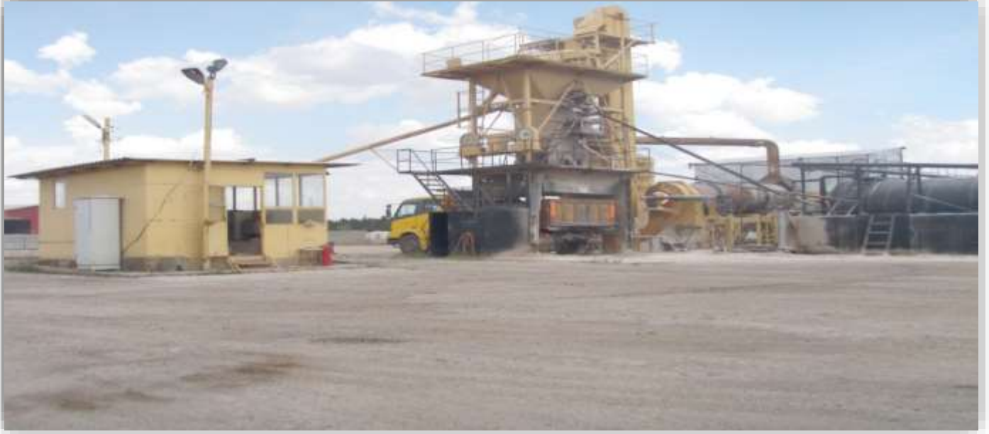
HAVSA ASFALT ŞANTİYESİ
